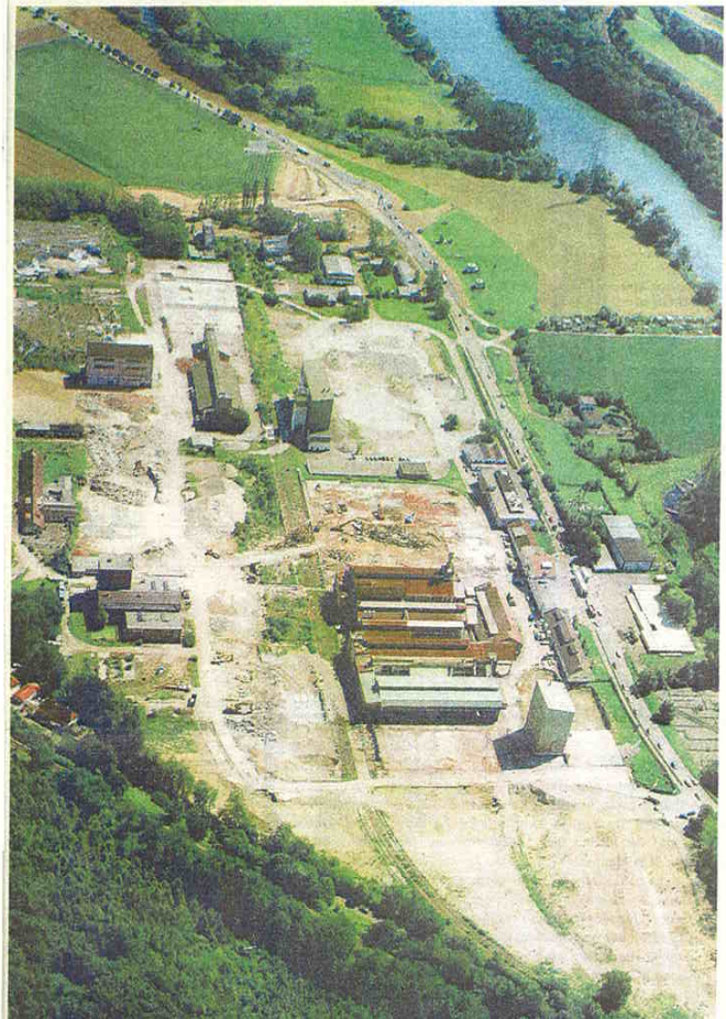
Gewerbepark Hochrhein aus der Luft gesehen. Von den ehemaligen Fabrikgebäuden der Lanza ist inzwischen in etwa die Hälfte abgerissen worden, um Platz für neue Gewerbebetriebe zu schaffen. FOTO: WIESMANN
